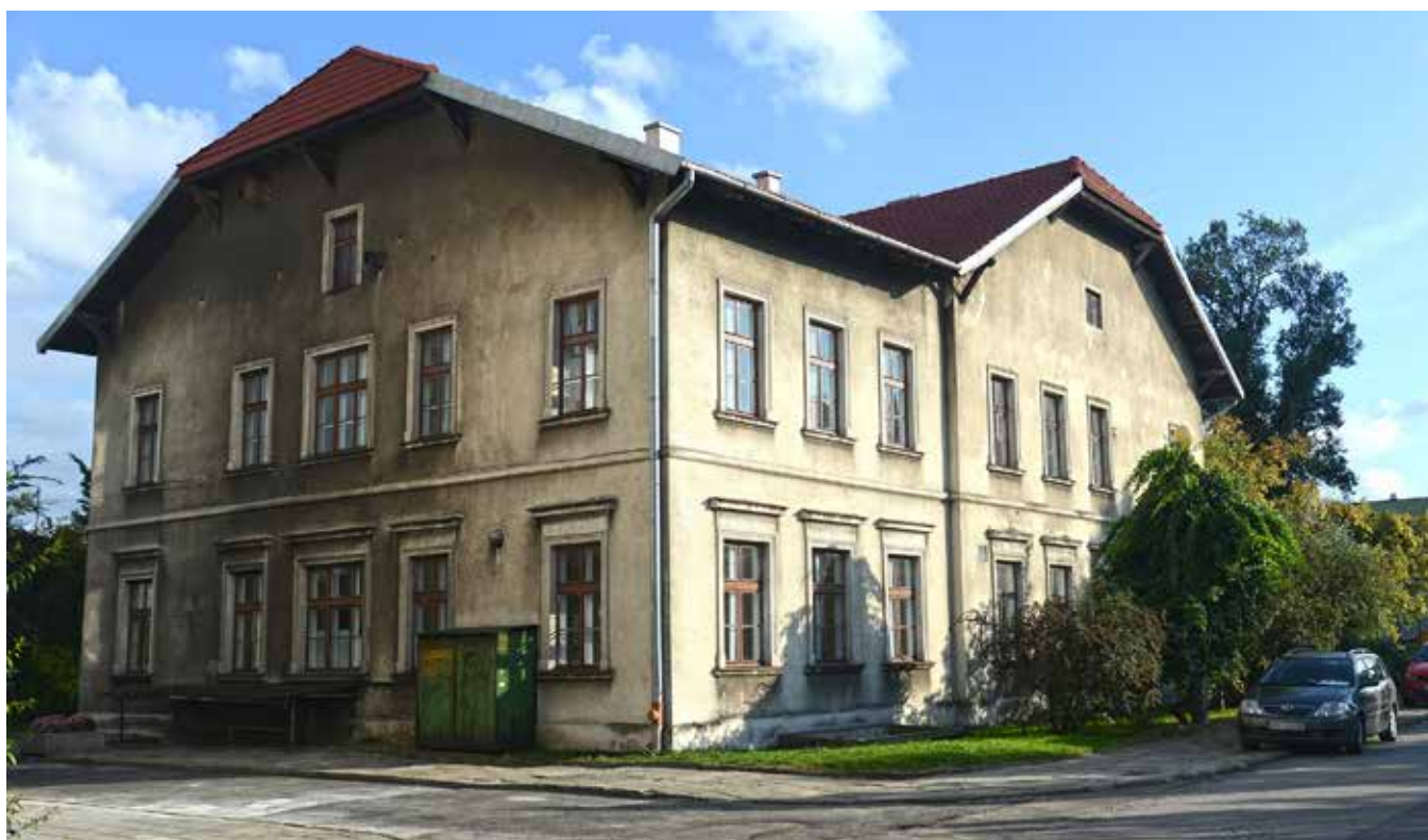
Po zakończeniu remontu Dworek Janczewskiego będzie prawdziwą perłą kampusu przy al. 29 Listopada
