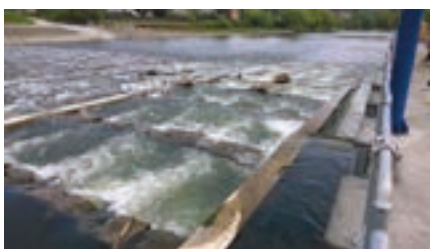
Przełławka dla ryb na rzece San w Przemyślu: góra: bystrotok – widok z lewego brzegu, dół: przełławka ryglowa – widok z prawego brzegu.
