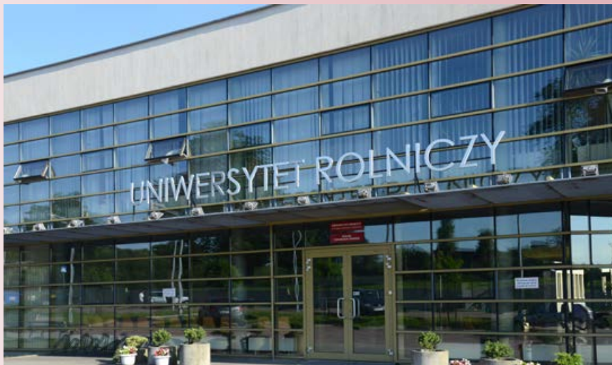
Budynek Wydziału Technologii Żywności
