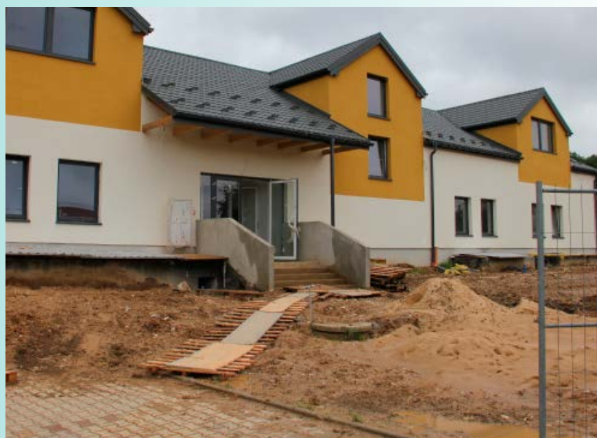
Prace budowlane na Bielanych – pierwszy budynek.
