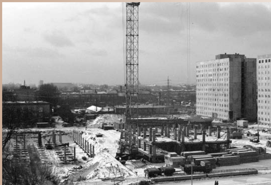
Budowa Wydziału Leśnego, rok 1977
