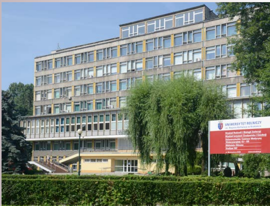
Budynek Jubileuszowy – siedziba władz Wydziału
