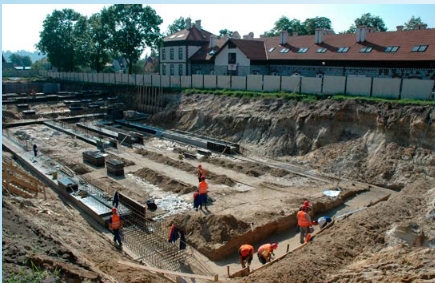
Prace przy wznoszeniu budynku dla Wydziału Inżynierii Środowiska i Geodezji w Mydlnikach
