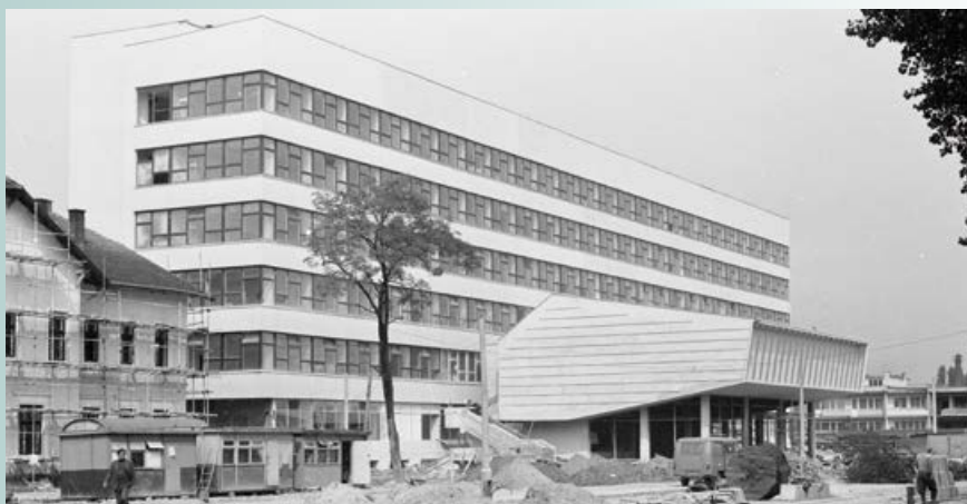
Prace przy wzniesieniu budynku Wydziału Ogrodniczego, 1976 rok
