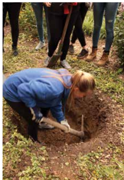
Wykopywanie gruzu betonowego
