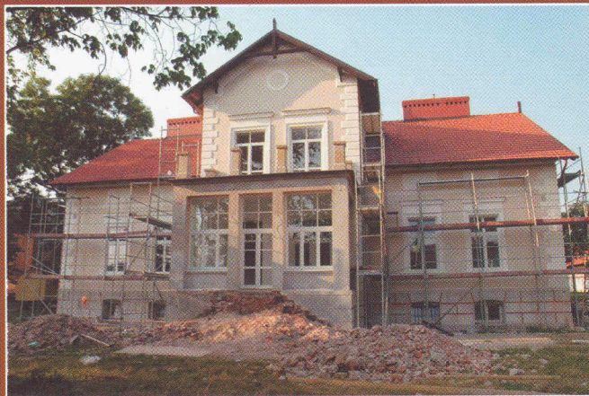
Dworek przed remontem
