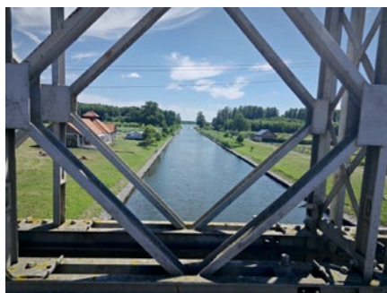
Widok z mostu Wrota Mazur na Kanale Jeglińskim ku jezioru Roś
