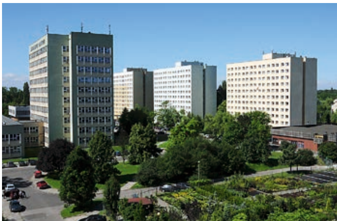
Kampus przy al. 29 Listopada, akademiki i budynek Wydziału Leśnego
