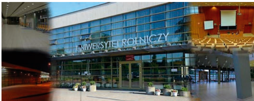
Budynek Wydziału Technologii Żywności
