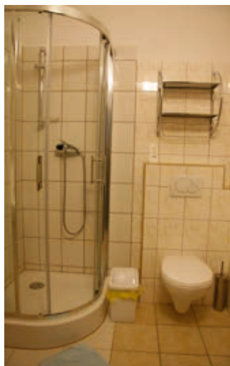
Wyremontowano również węzły sanitarne, fot. Sławomir Szarek
