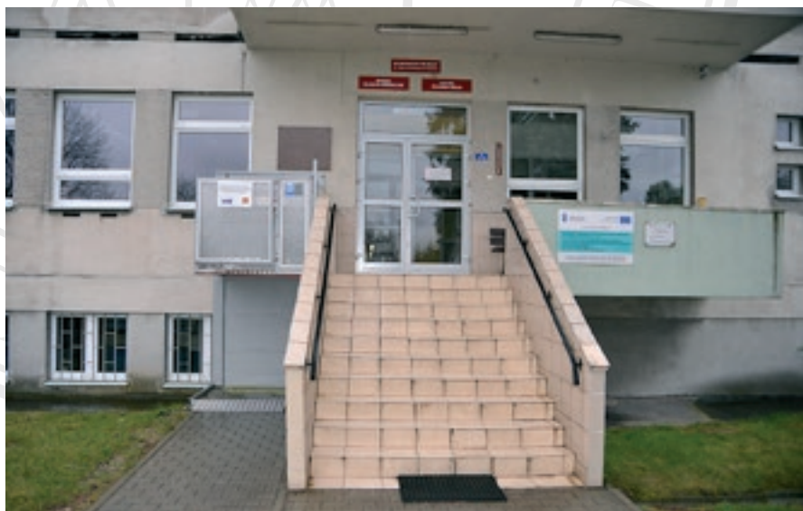
Dostosowanie budynku FITOTRON do potrzeb osób z niepełnosprawnością
