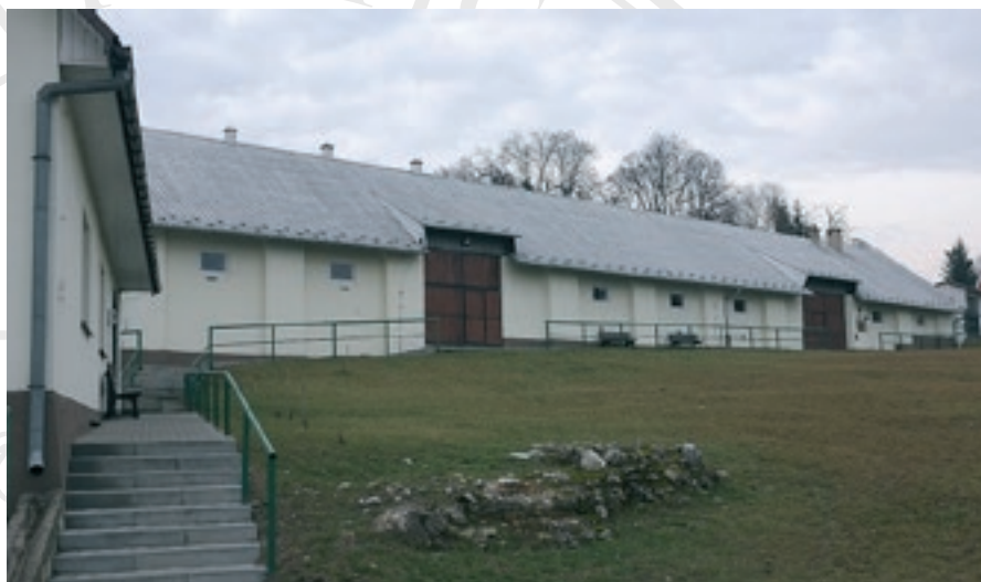
Dostosowanie budynku Stajni Dolnej w Przegorzalach do potrzeb dydaktycznych
