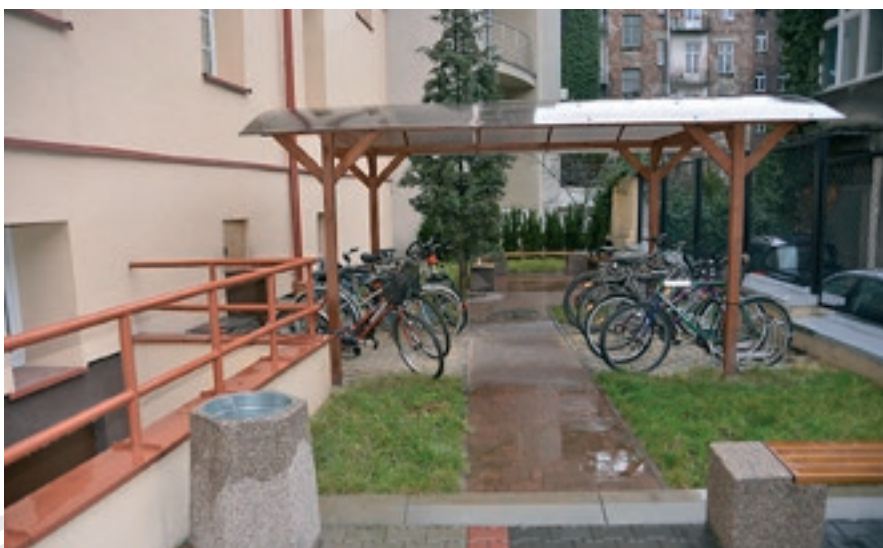
Dom Studencki Bratniak – przebudowa podwórza wewnętrznego
