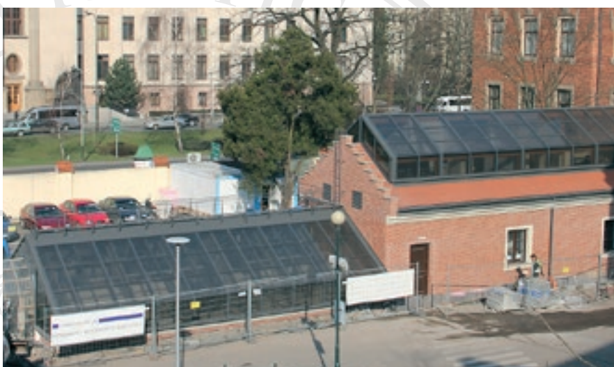
Remont budynku Pojnarówki i Szklarni
