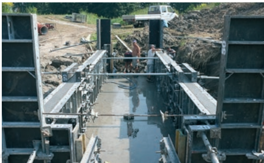
Remont budowli hydrotechnicznych na terenie RSD w Mydlnikach
