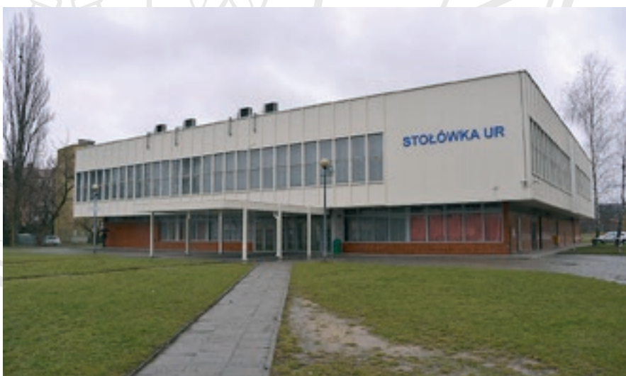
Remont elewacji i oświetlenia zewnętrznego Stołówki UR
