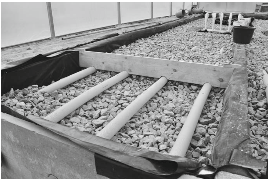
Widok akumulatora na etapie budowy
