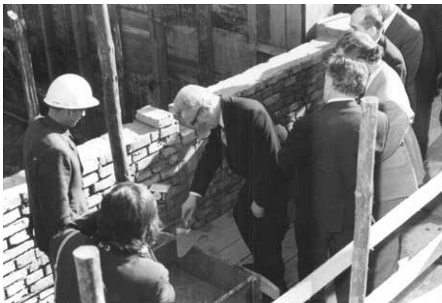
Prace budowlane rozpoczęły się w 1974 r.: umurowanie cegielki przez prof. Tadeusza Wojtaszka
